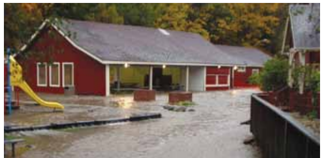
Covenant Beach Camp (1917-1957), 2006 flood, Des Moines
