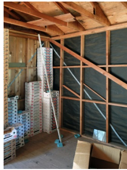
Fig. 12b. SE corner.
