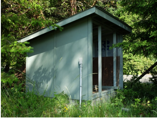
Fig. 25. SW elevation No.25.
