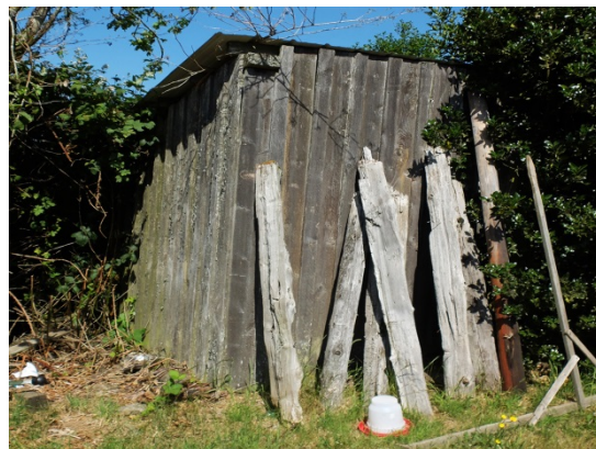
Fig. 28. SW elevation. No.30.
