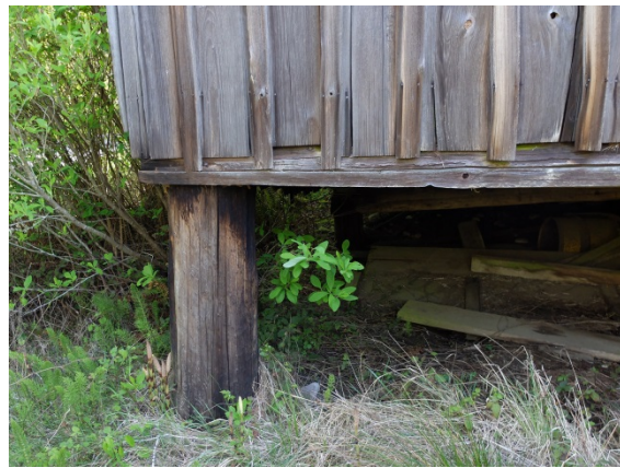
Fig. 9e. Imbedded pole columns.
