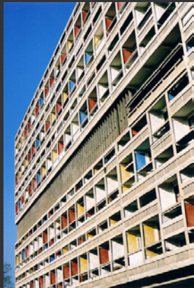
Unite d' Habitation Le Corbusier, Marseilles, France, 1946-52
